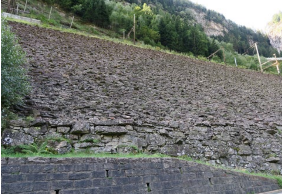
Eine Trockenmauer zur Geschichte der Gotthardbahn: Eine rollierte Böschung mit Steinsatz als Erosionsschutz für Bahn und Strasse.
